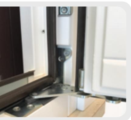
Le cerniere a scomparsa con portata 150 Kg, permettono la realizzazione di finestre e porte finestre di grandi dimensioni garantendo sempre resistenza all'effrazione.
